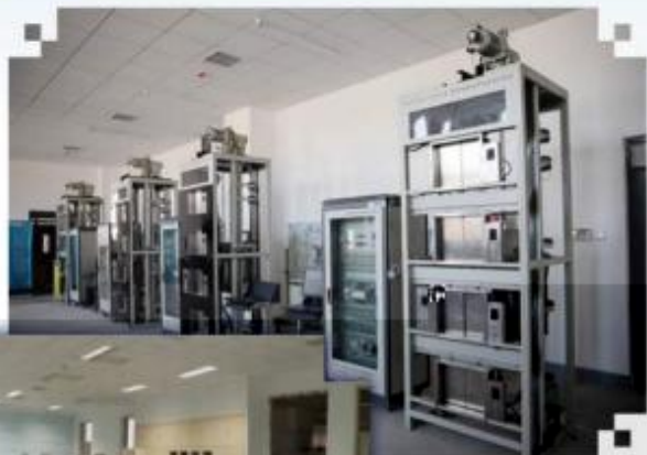
智能电梯安装调试 维护训练场所
